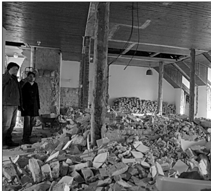
A tetőtéri felújítás bontással kezdődött
