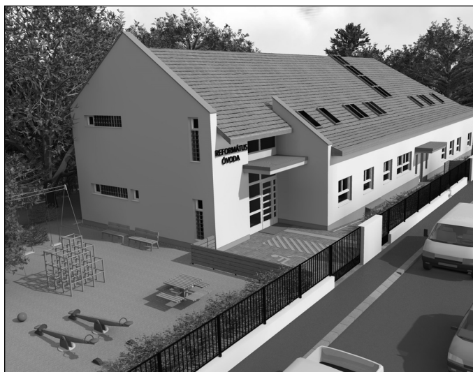
Megújult tető az óvodánkban
